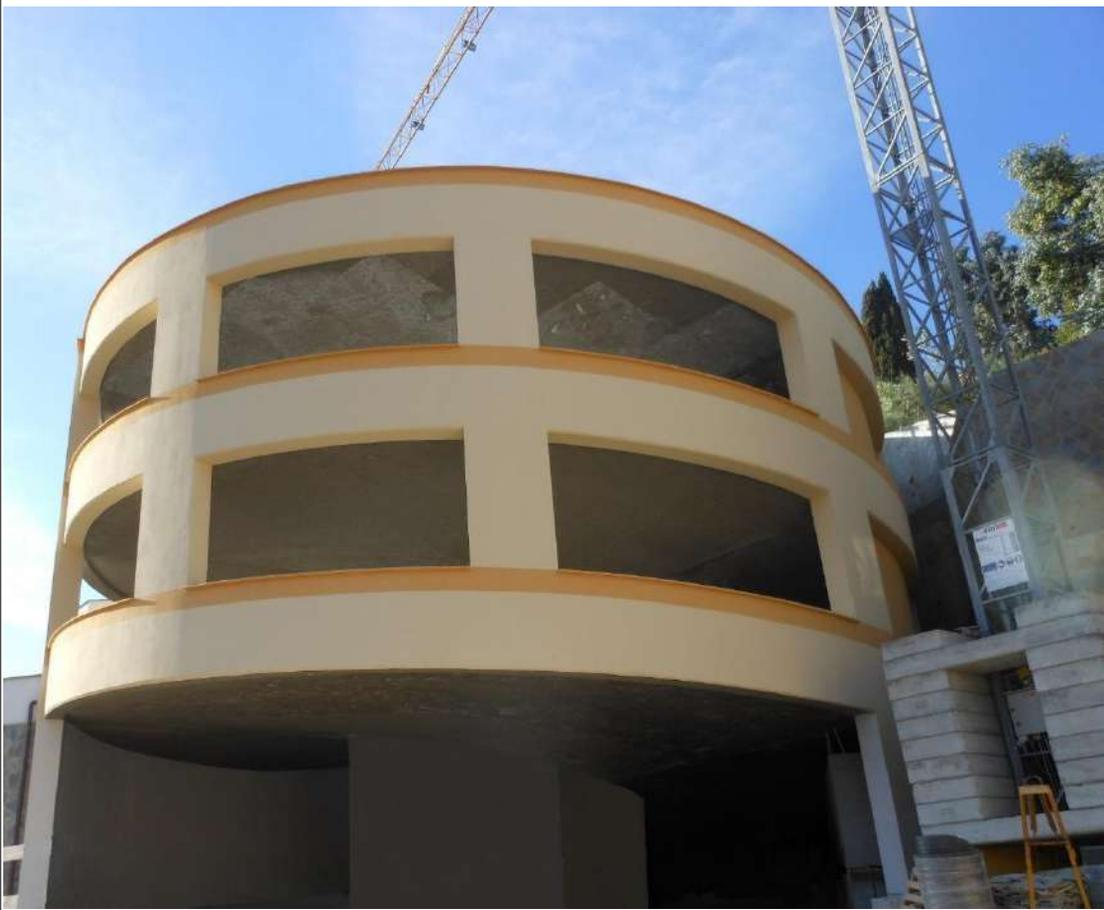
TRAVE VIERENDEEL CURVA Campata 22m - Cantilever 7,5m portata massima 1000kg / mq Calcolo di modellazione agli elementi finiti
