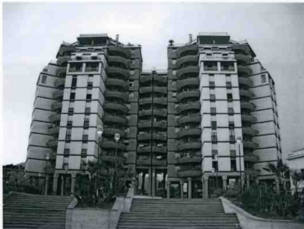
Costruzione n.2 edifici denominati “le Torri di Colombo” ad Arma di Taggia (IM) Importo Lavori Euro 20.000.000,00
