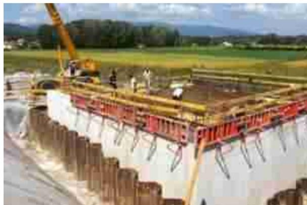
Figura 18: Impianto idrovoro: realizzazione del solaio di piano
