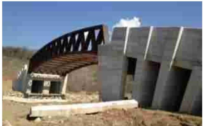
Figura 2: Struttura metallica d'impalcato.
