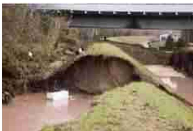
Figura 95: Rottura arginale di valle
