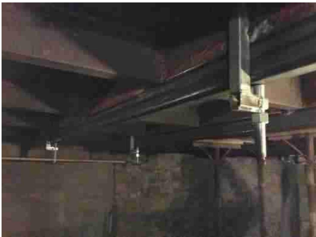
*Figura 48: Inserimento dei profili tubolari di rinforzo.*
