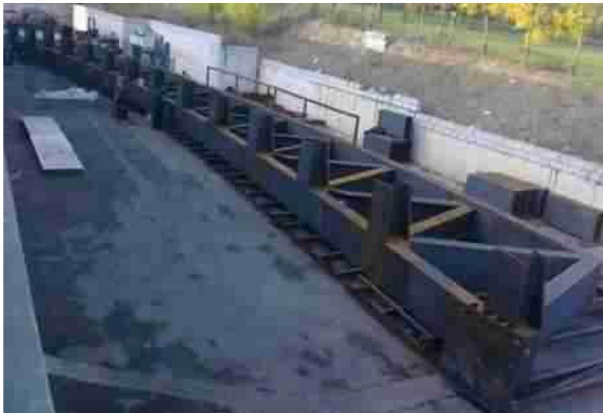
*Figura 7: Assemblaggio fuori opera delle travi principali.*
