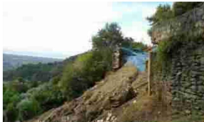
Figura 104: Cedimento della gabbionata, vista laterale.
