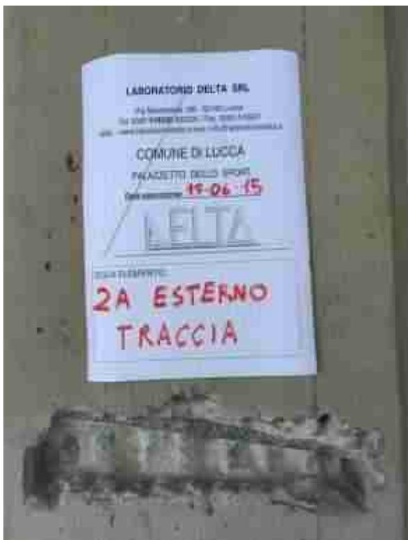
Figura 71: Realizzazione delle tracce.
