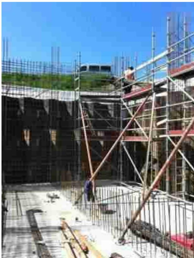
Figura 17: Impianto idrovoro: Realizzazione della vasca
