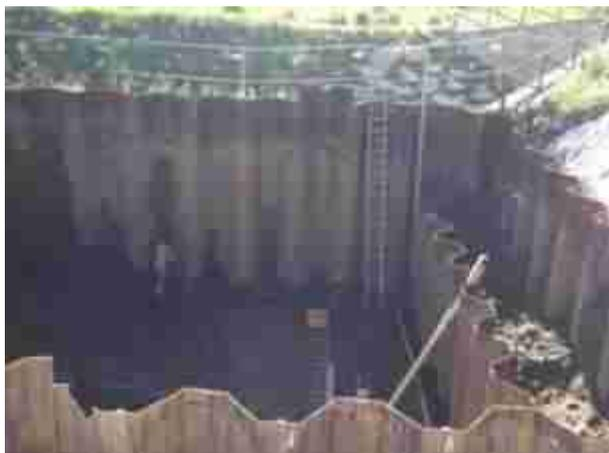
Figura 14: Impianto idrovoro: Predisposizione del palancoato per la realizzazione della vasca
