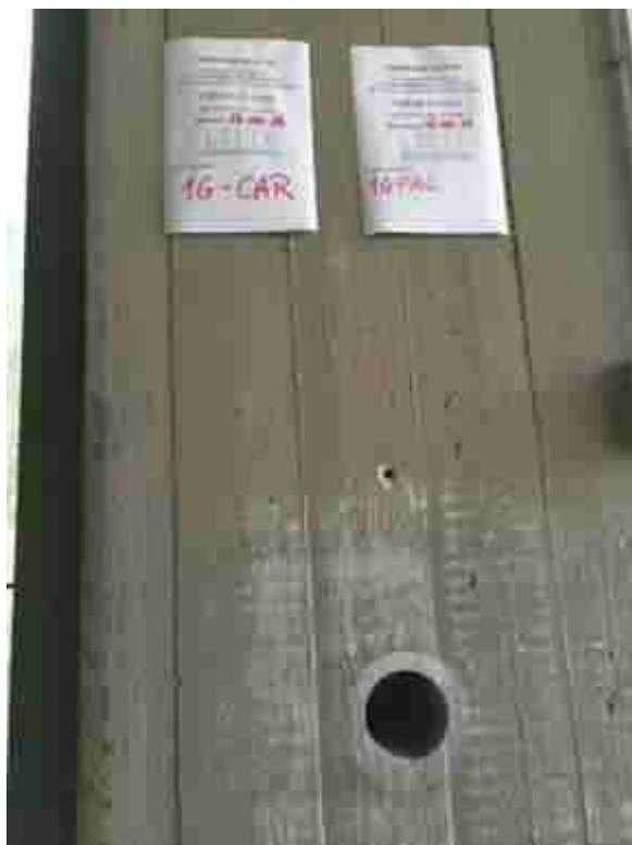
Figura 68: Estrazione delle carote.
