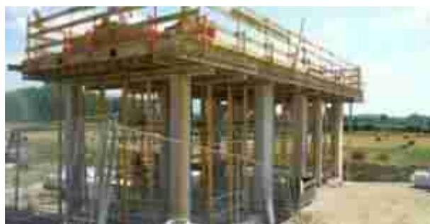
Figura 19: Impianto idrovoro: realizzazione delle pilastrate e del solaio di copertura
