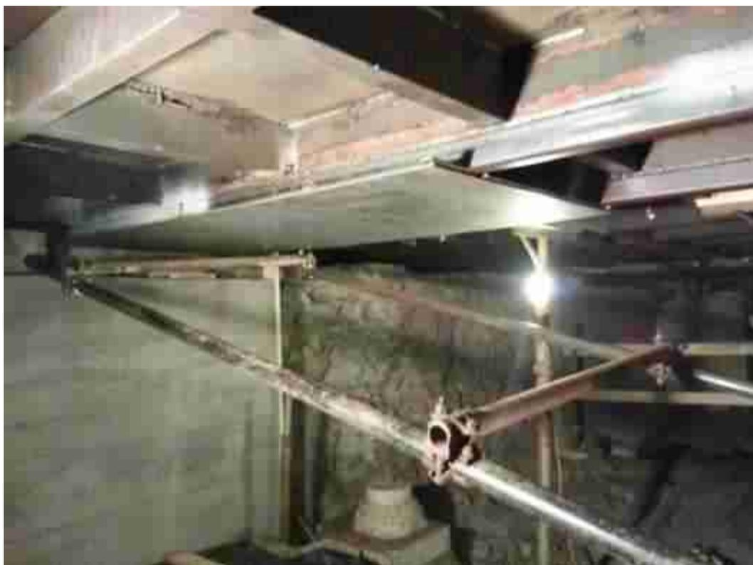
*Figura 49: Inserimento delle piattabande aggiuntive.*
