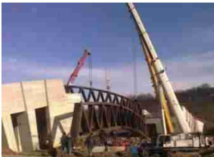
*Figura 9: Varo delle travi principali.*
