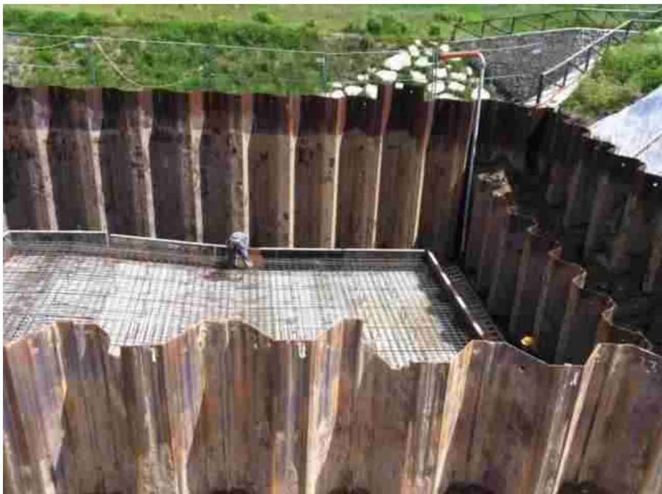
Figura 16: Impianto idrovoro: particolare del doppio palancoato.
