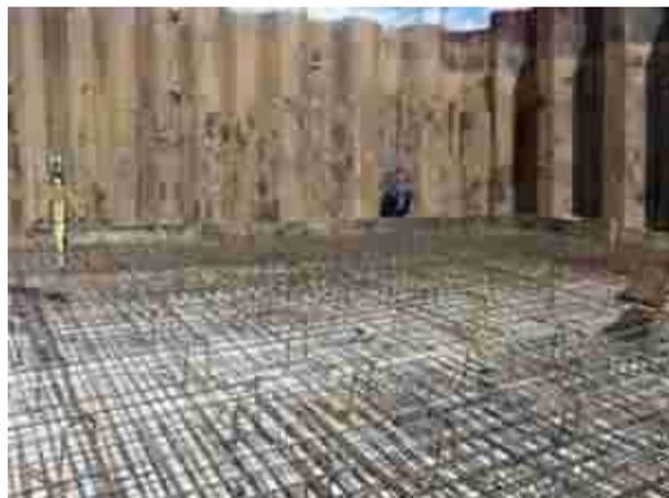
Figura 15: Impianto idrovoro: realizzazione della platea di fondazione.
