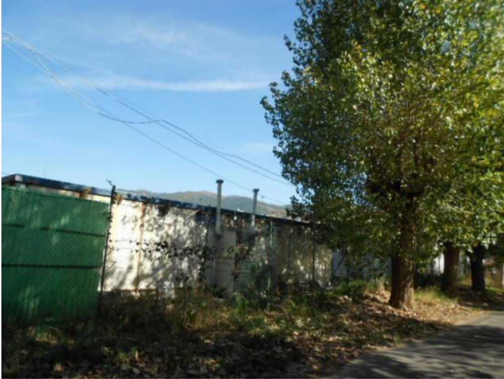
Figura 12: spogliatoi prefabbricati esistenti
