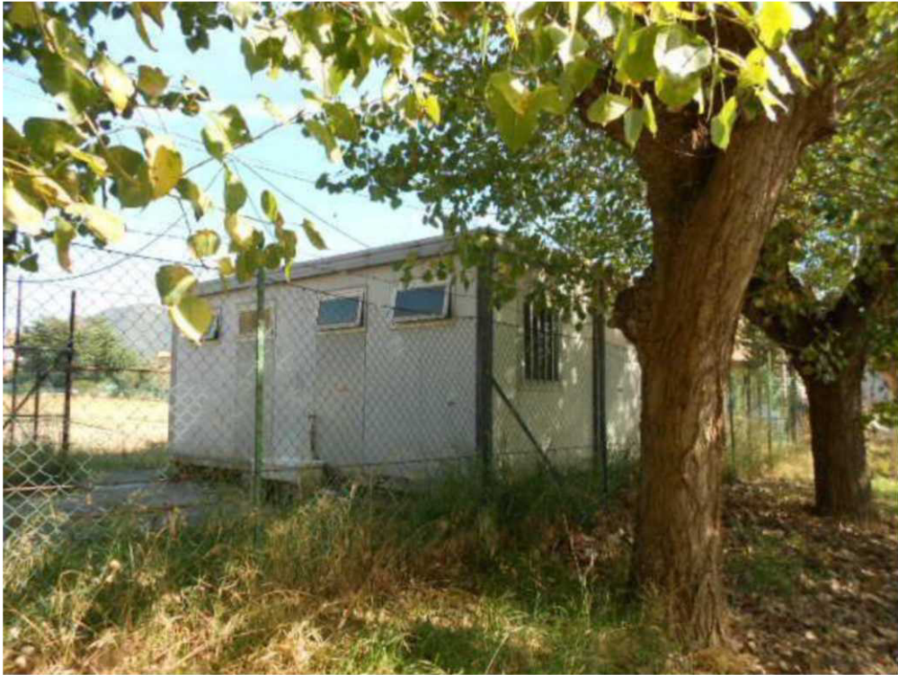
Figura 10: spogliatoi prefabbricati esistenti
