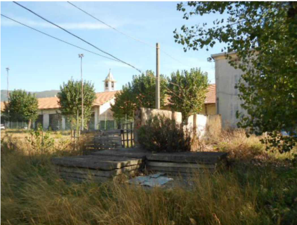
Figura 8: recinzione lato ovest
