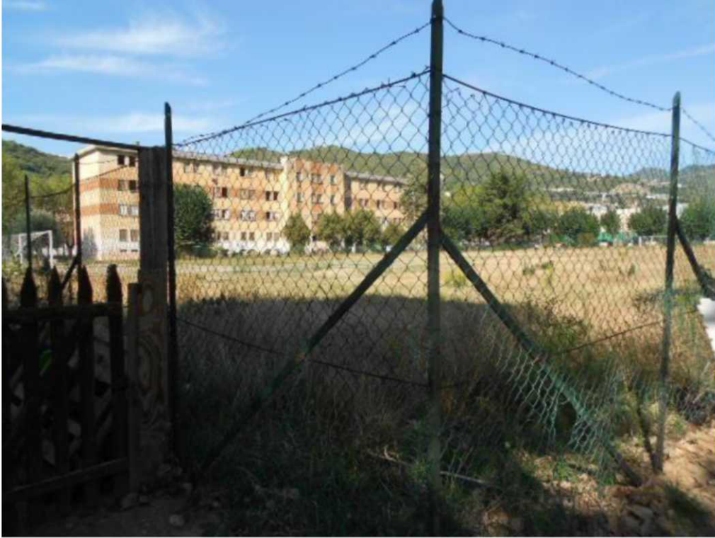
Figura 7: recinzione esistente lato sud
