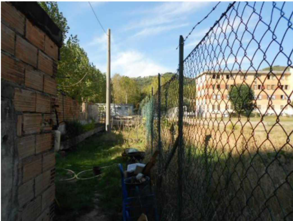
Figura 6: recinzione esistente lato sud
