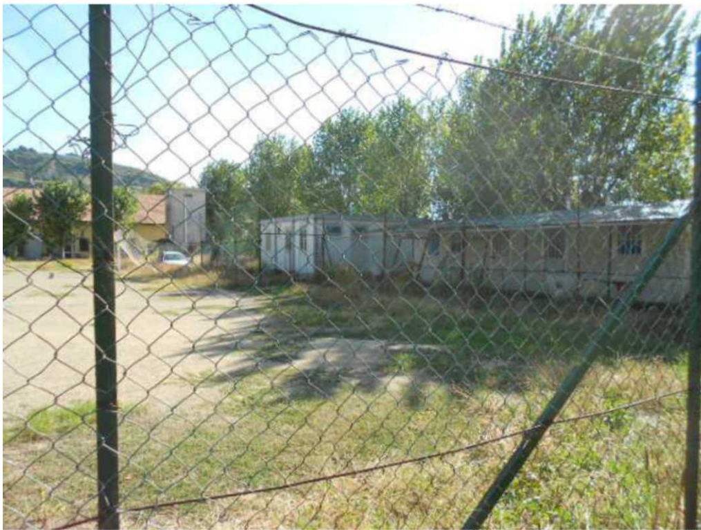
Figura 19: spogliatoi e servizi igienici esistenti posizionati sul lato
