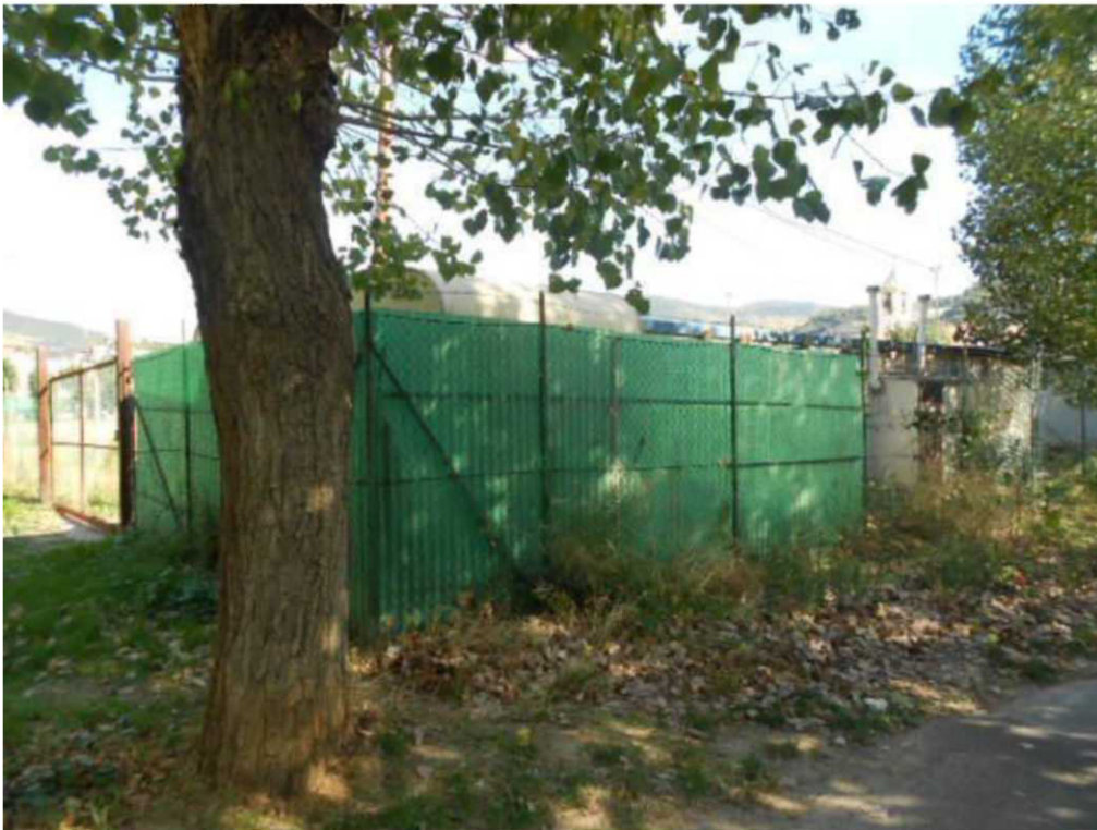
Figura 13: recinzione lato sud
