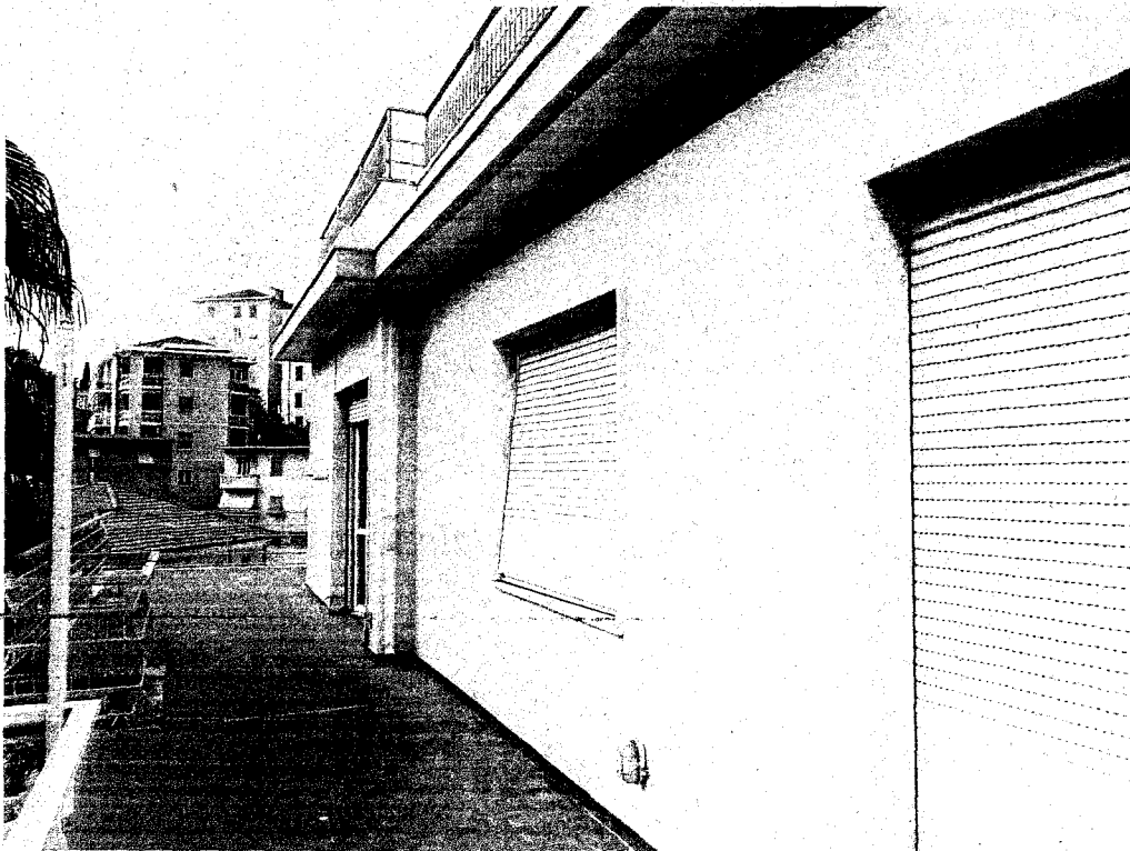
FOTO TERRAZZA DAL LATO EST
