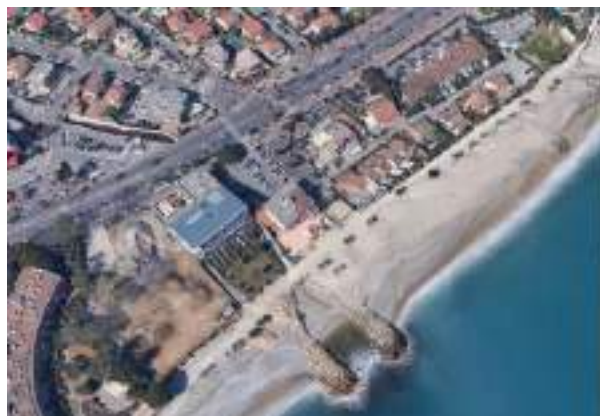
Exutoire du vallon «Pied de Digue» : jetées en enrochements érodées, plage en érosion
