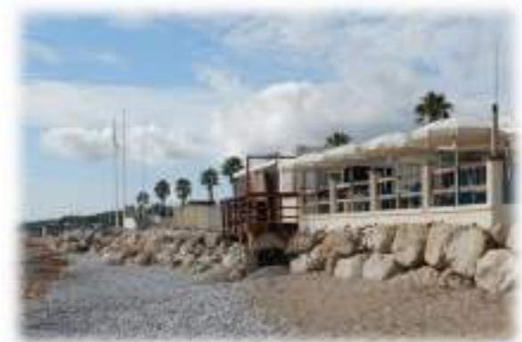
Perré en enrochements protégeant les restaurants et le parking
