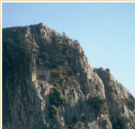
Feritoia mitragliatrice (centro di fuoco 3)
